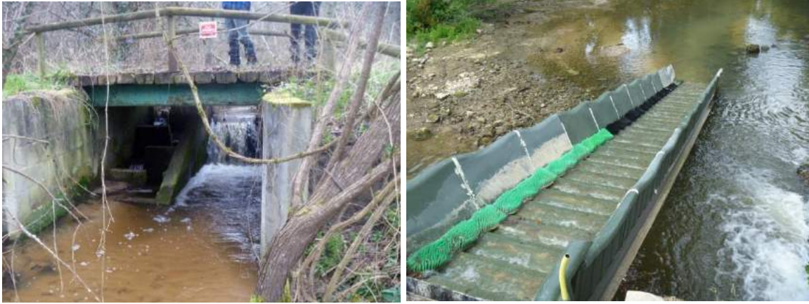
Figure 34 : Passe à bassins successifs sur le Capignon (Gauche) et Tapis brosse pour l'anguille sur une passe à canoë à Andiran (Droite)
