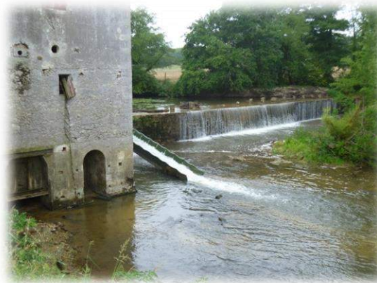
Figure 32 : Seuil déversoir du moulin d'Andiran
