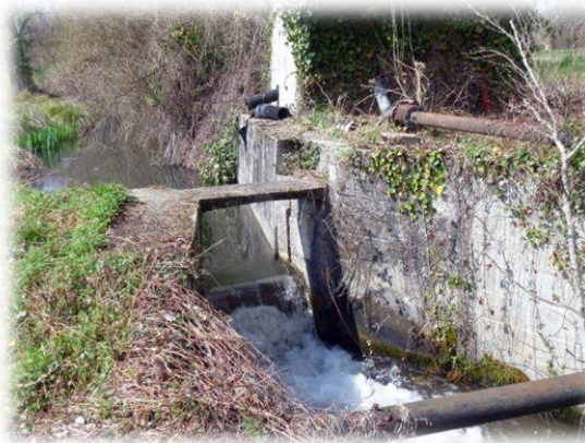
Figure 33: Seuil fixe sur le Criéré
