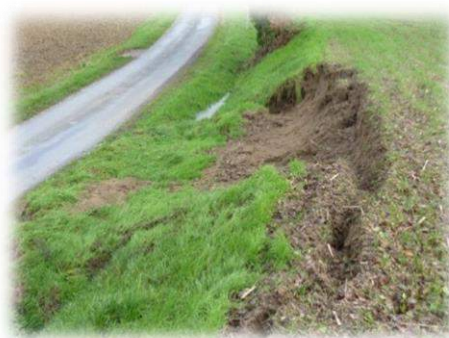
Figure 95 : Effondrement de talus
