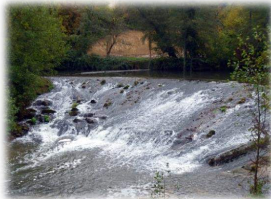
Figure 31 : Seuil déversoir en pente du moulin d'Estabaque
