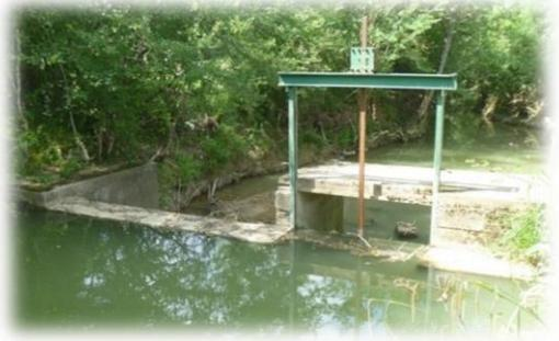
▲ **Clapet à bascule** : Ouvrage constitué d'un clapet permettant de réguler automatiquement le débit grâce à un système de contrepoids.
