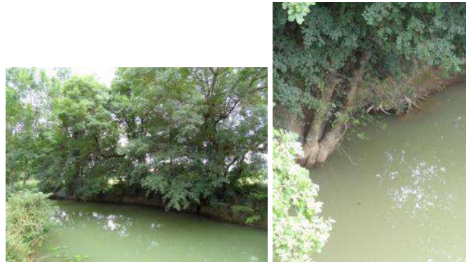
Exemple d'érosion en zone externe de méandre (gauche) et systèmes racinaires et zones d'affouillements en berges (droite)
