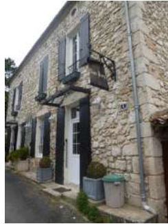
Bâtisse traditionnelle en R+1+combles à l'entrée du vieux-bourg
