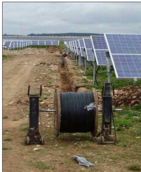
*Creusement des tranchées et passage des câbles électriques*
