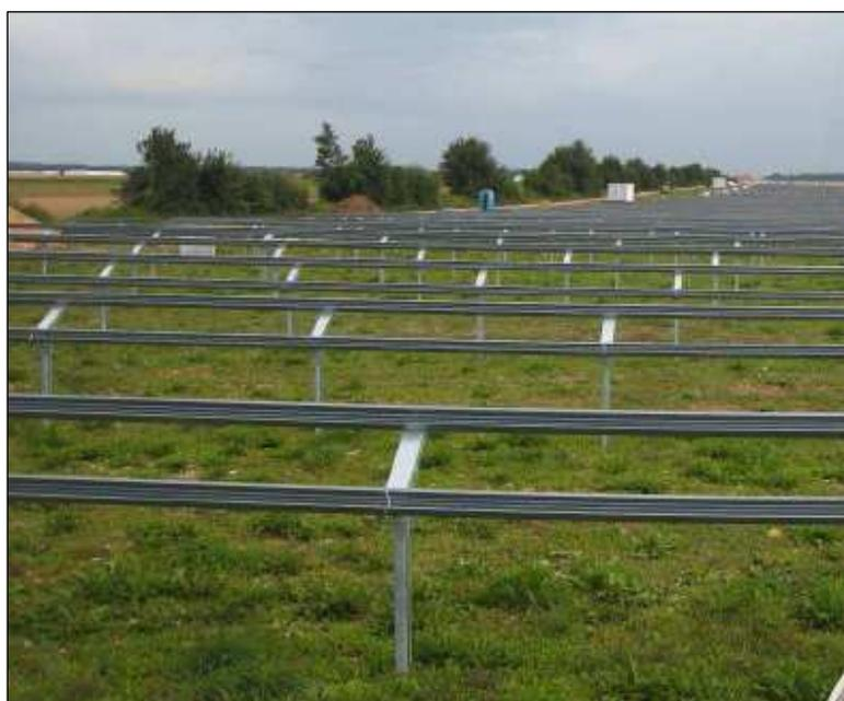
*Fixation des pieds et des systèmes de support (source GP Joule GmbH)*
